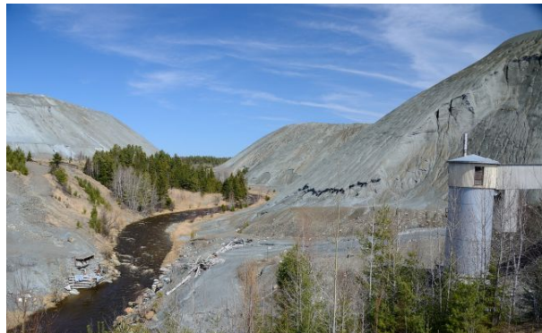
Photo 4 Érosion des haldes de résidus miniers 24 avril 2013 (Éric Gagnon Poulin, Courier Frontenac)
