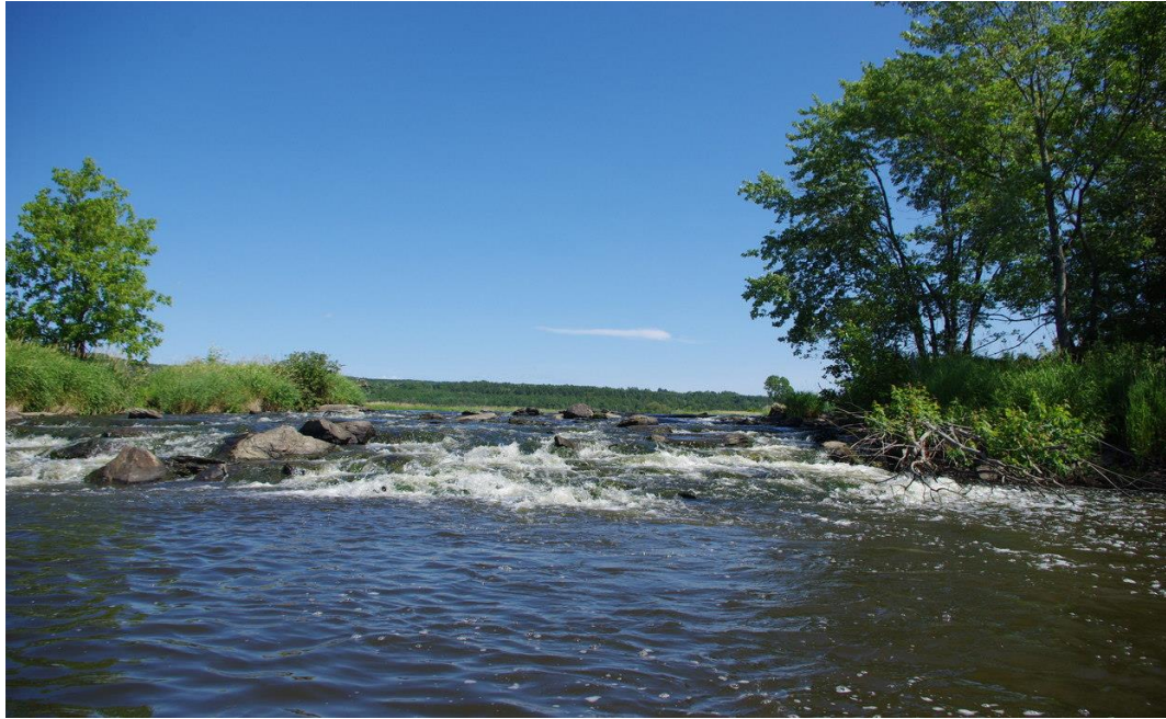
Photo 6 Vue de l'aval sur le déversoir.
